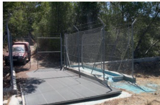
Foto 8. Pediluvio y fosa de hormigón provista de una cubierta abatible
